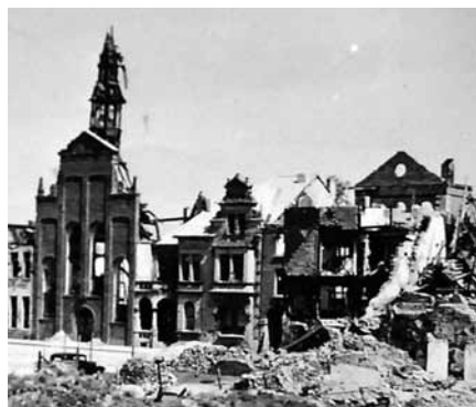
Blick auf die Trümmer der kriegszerstörten Kirche und der nebenstehenden Häuser
